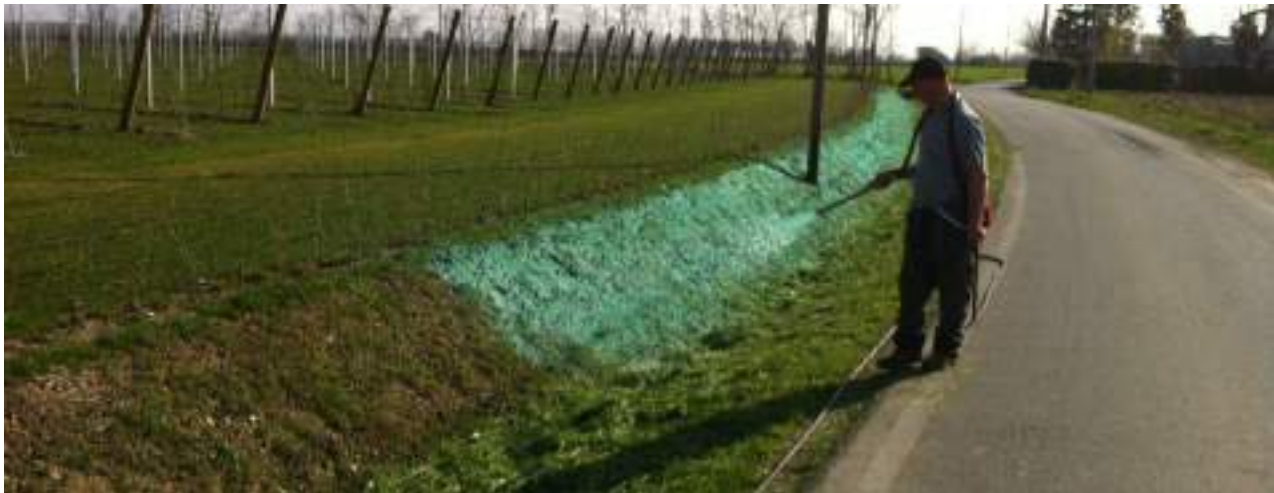
Figura 28 – Tecniche di idrosemina
